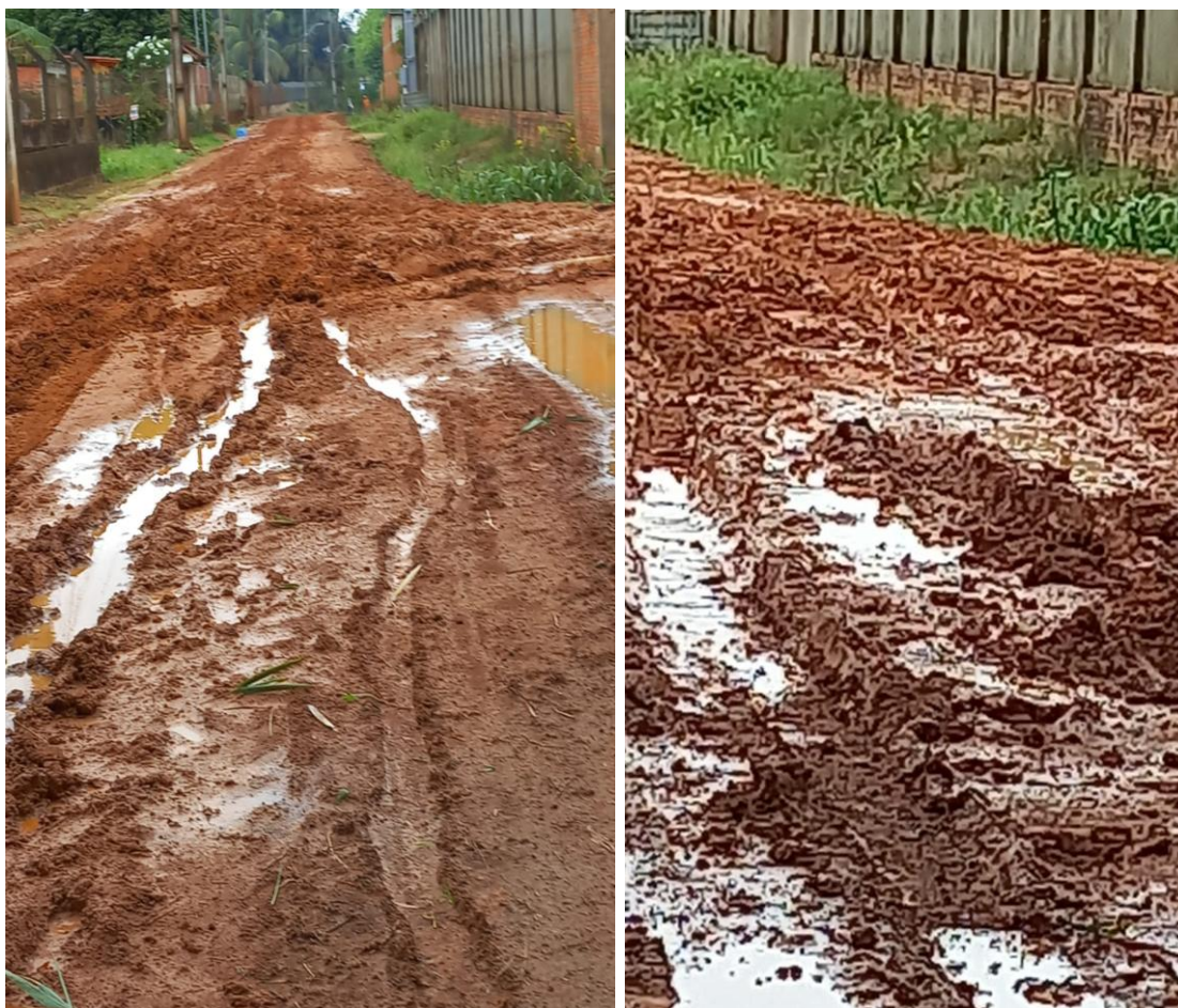
Figura 1—Rua necessita de Pavimentação asfáltica
