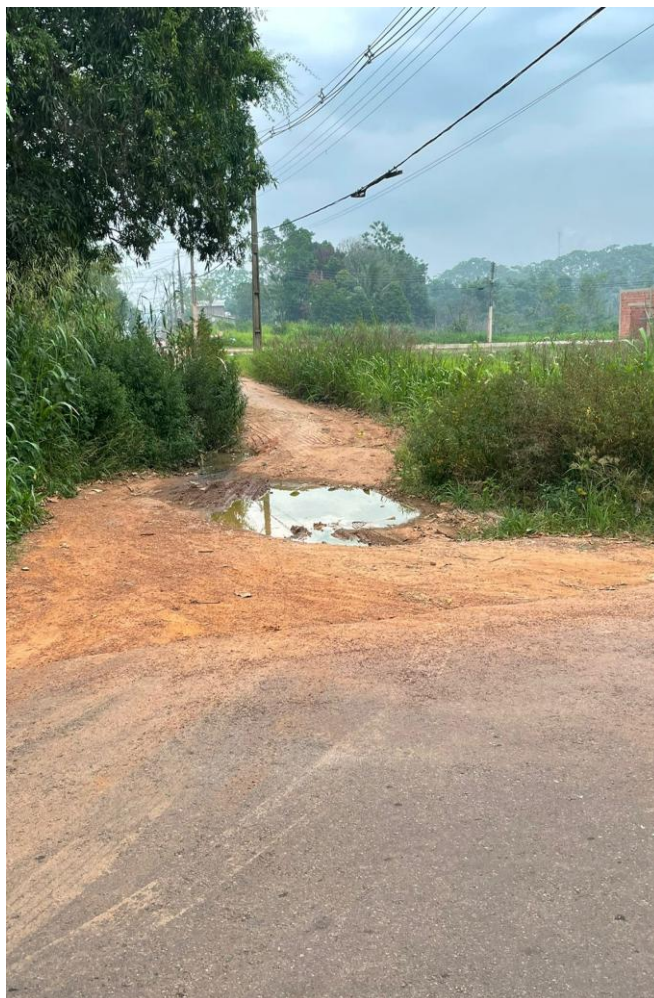
Figura 1– Rua necessita de Pavimentação asfáltica
