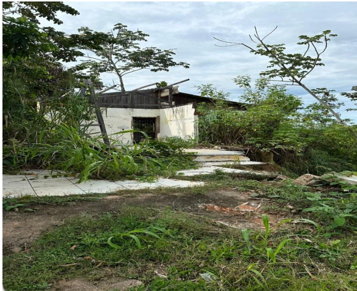
Figura 3– A rua necessita de um projeto para evitar a erosão.
