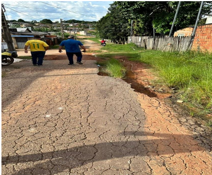
Figura 1 – Aspecto geral da Rua Precisa.
