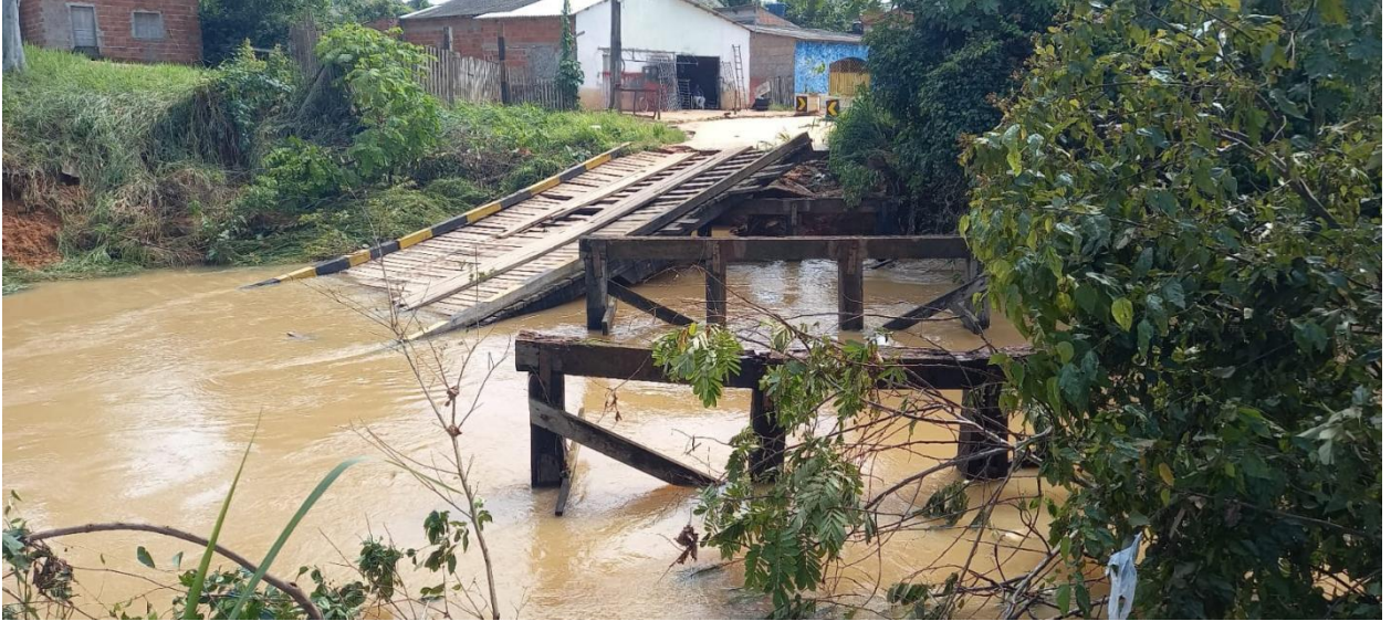
Ponte sobre o Igarapé Judia
