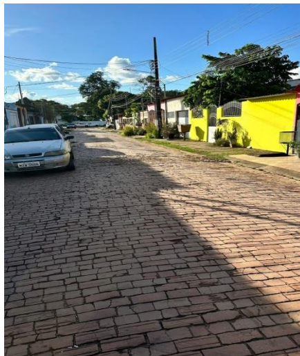
Figura 1 – Aspecto geral da Rua Francisco Montilha.
