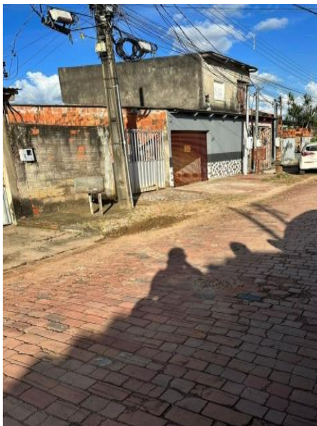
Figura 2 – A rua necessita de pavimentação e calçamento para os pedestres.
