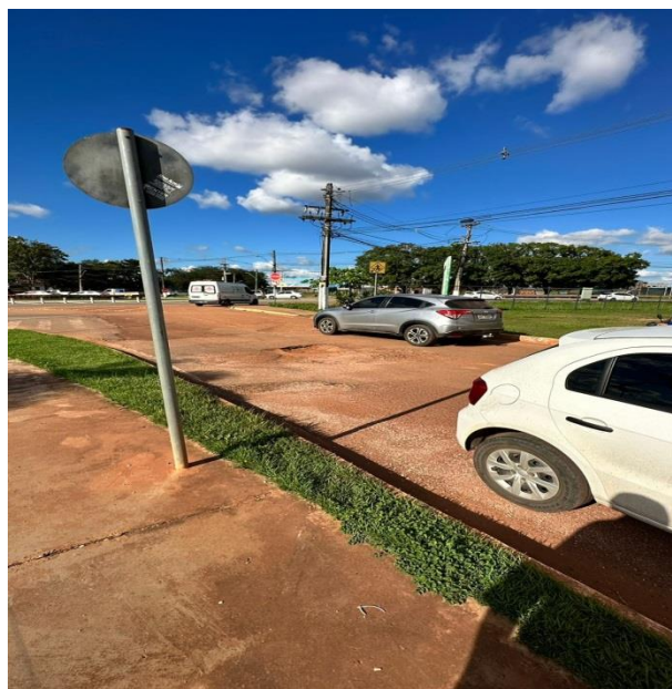
Figura 2 – A alameda necessita de pavimentação, calçamento, passagem externa para pedestres coberta.
