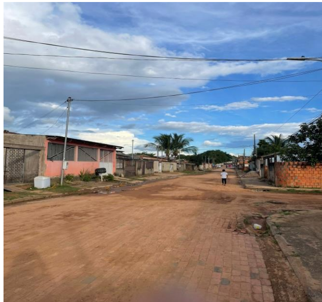
Figura 1 – Aspecto geral da Rua Iolanda Lima.
