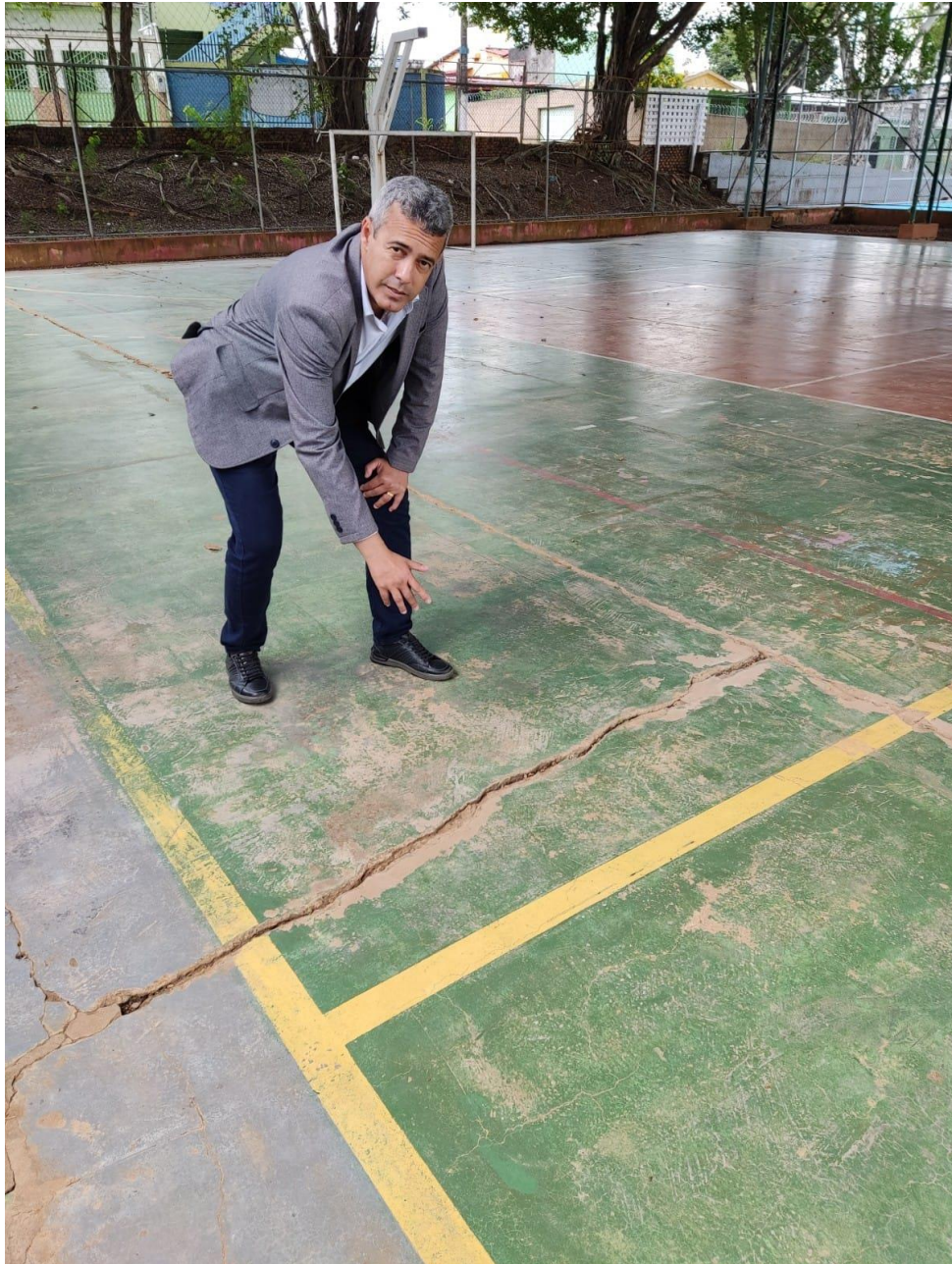
Figura 3 – Rachaduras por todo o piso da quadra.
