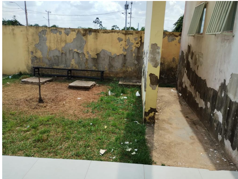
Figura 3– Manutenção Predial II.
