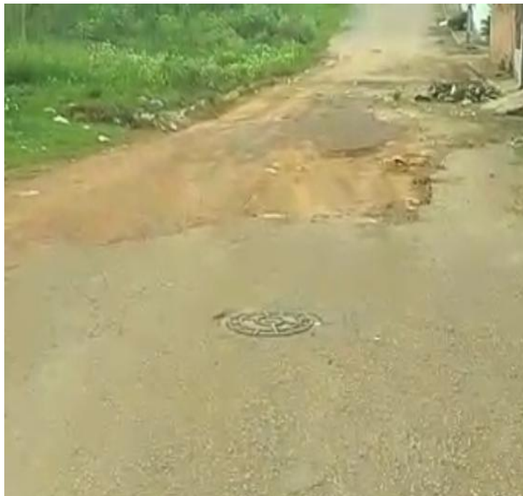
Figura 2 – Aspecto geral da na Rua gaivota, Conjunto Adalberto Sena.
