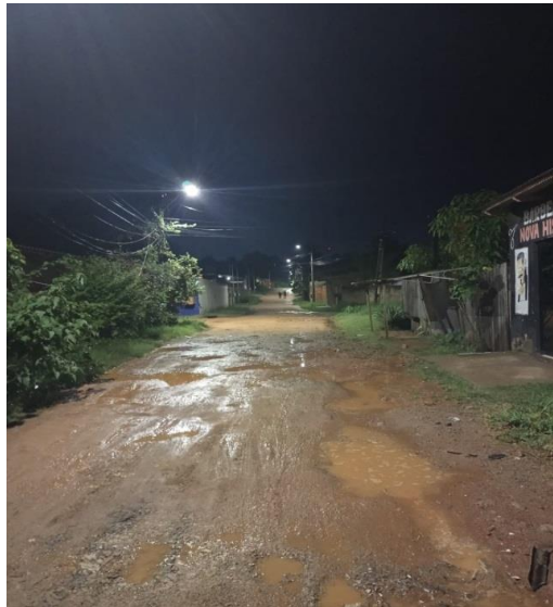
Figura 3– A rua necessita de pavimentação e calçamento.
