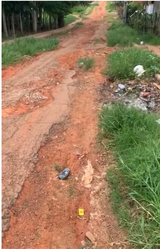
Figura 3– Pavimentação, calçamento, saneamento básico, instalação de bueiros.
