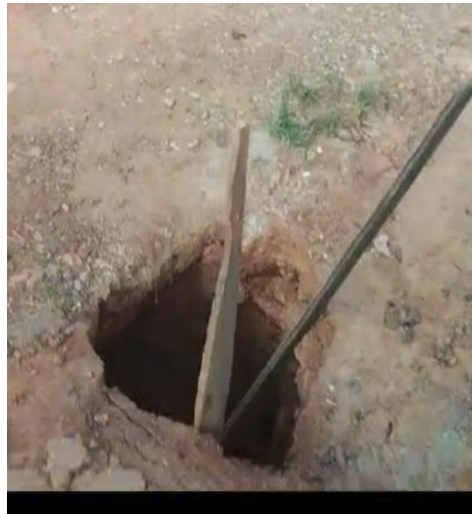
Figura 3– Pavimentação, calçamento, saneamento básico, instalação de bueiros.
