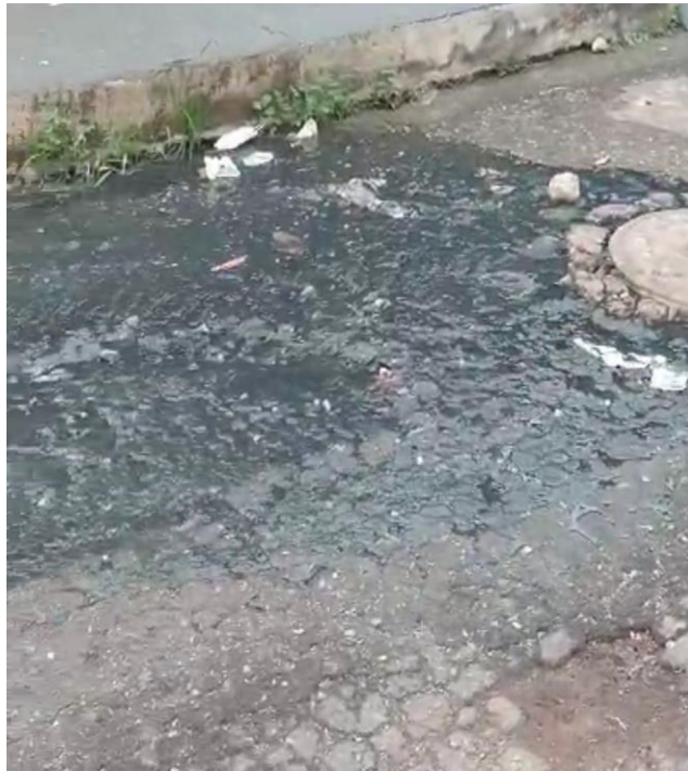
Figura 3– Pavimentação, calçamento, saneamento básico, instalação de bueiros.
