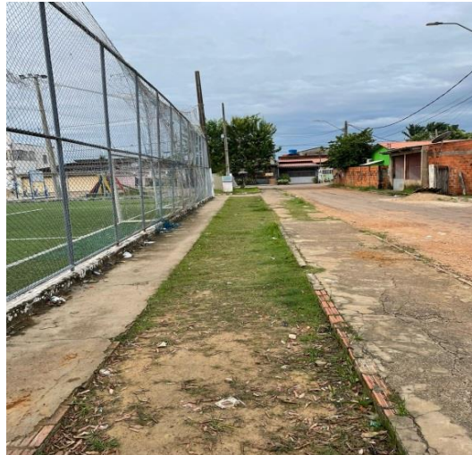
Figura 3– Quadra de grama sintética, realizar a manutenção do local e realizar a construção da cobertura da mesma.
