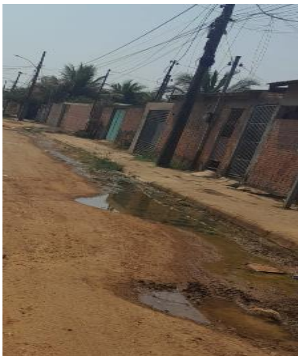
Figura 1 - Aspecto geral da Rua do Sol, localizada no bairro da Sobral.
